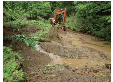
林道の補修作業
