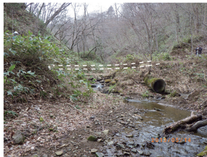
補修前の林道。点線が林道があった場所。 小沢によって、林道が寸断されていた。
