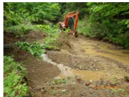
林道の補修作業
