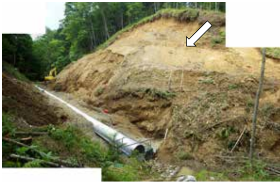
第二次発掘前の事前工事(2014年7月31日)。工事で掘削された岩石置き場の下に沢の水を流すパイプを設置。矢印がカムイサウルスが埋没している場所(下の写真も同様)。
