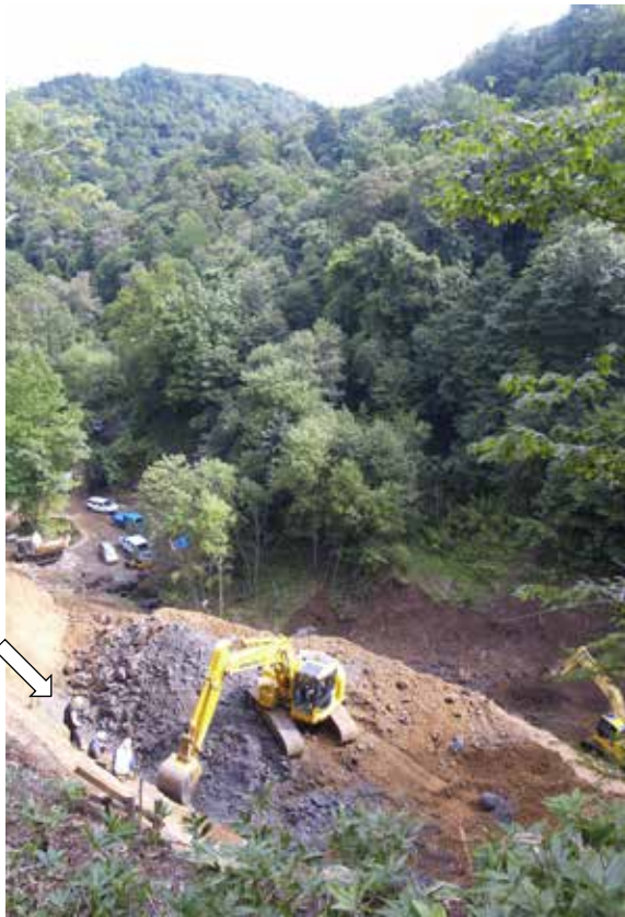
重機を使った事前工事(2014年8月21日)。沢側に掘削で生じた岩石を移動させている。
