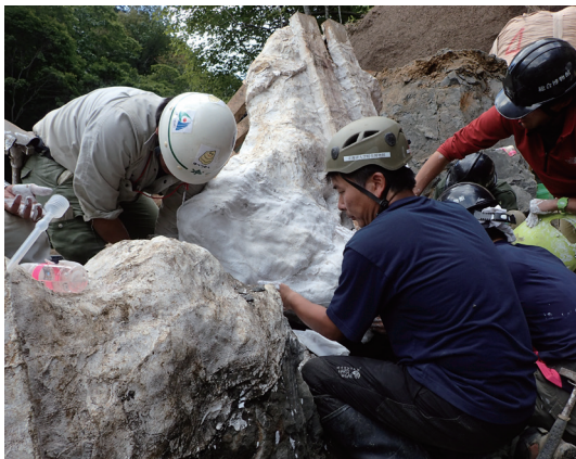
大型石こうジャケットの製作
