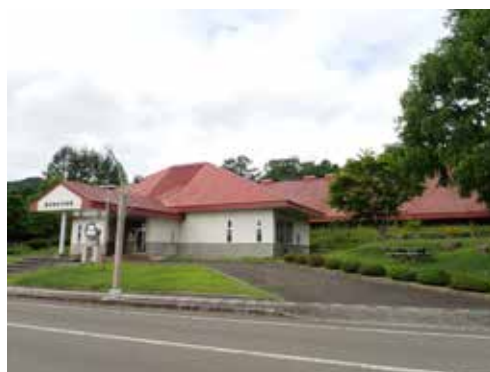
撤去される予定の(旧)穂別地球 体験館
