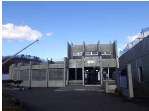
きぞん かいしゅう 既存の博物館の改修も始まりました。屋上の ぼうすい 防水工事が行われています。屋上に網が張ら れて、工事が進められています。(11/21)
