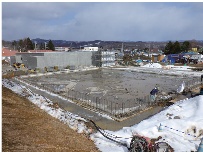
手前が新博物館建物の基礎。写真奥が隣接する温浴カフェ (3月8日撮影)
