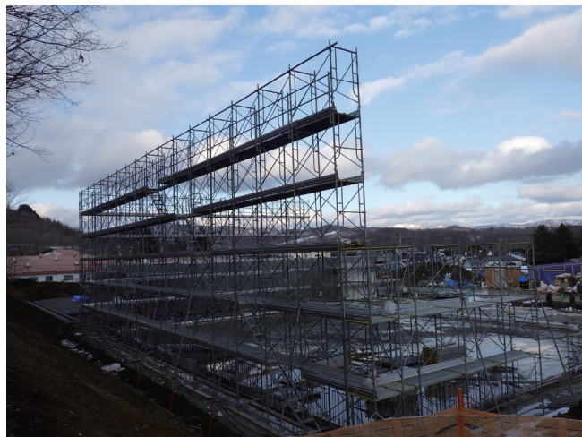
新博物館建設のための足場 (3月15日撮影)
