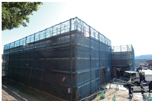
けんせつ 建設中の博物館新棟。斜め後ろ側か ら (7月24日撮影)
