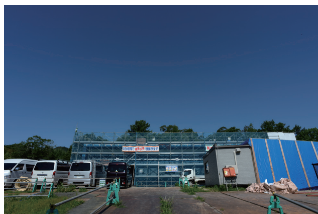
建設中の博物館新棟。正面 (7月24日撮影)
