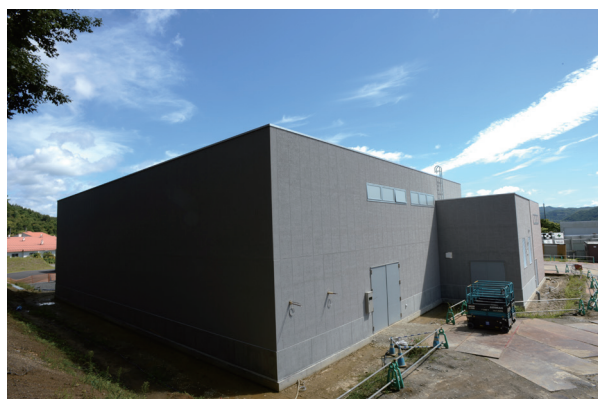
なな 斜め後ろ側から
