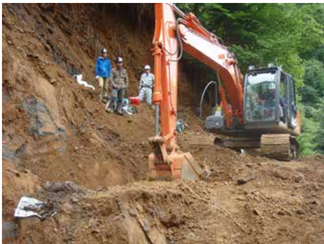
重機で化石層の下位側を掘る (9/7)
