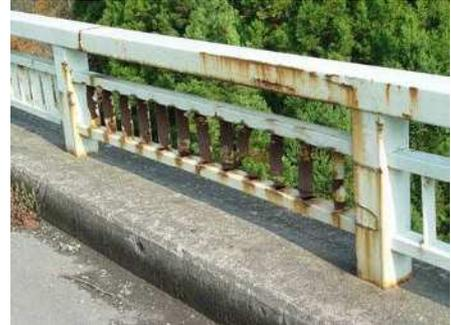
写真1 高欄部材の欠損
