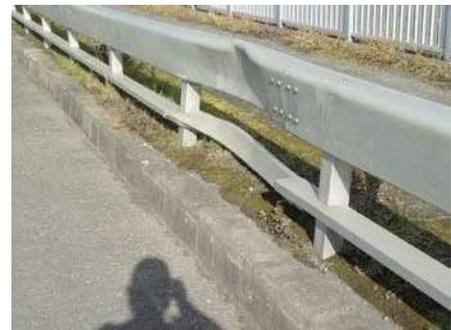
写真2 防護柵の著しい変形
