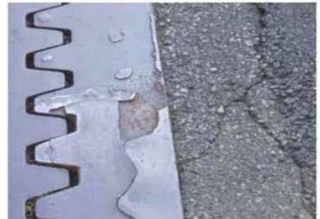
写真3 伸縮装置の欠損
