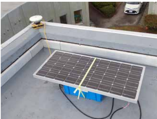
北海道大学地震火山研究観測センターによる観測機器設置
