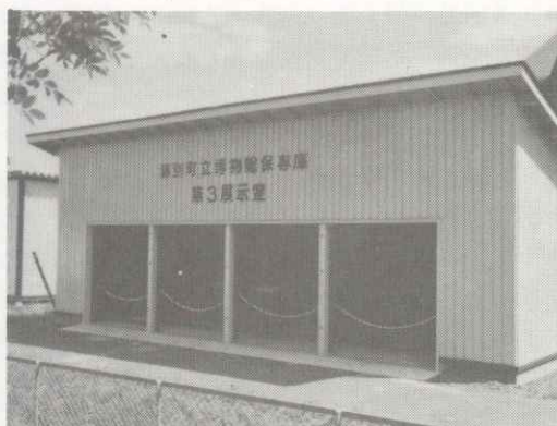
「保存庫・第三展示室外観」
