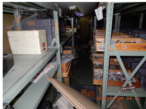
図9. かせき学習館収蔵庫地震被害。2018年9月6日～8日撮影。A–C, 収蔵庫1階。スチール棚に転倒被害が見られた。むかわ竜化石を収蔵していた樹脂製コンテナは移動・転倒しなかった。D, 収蔵庫2階。棚が移動し、通路が狭くなっている。
