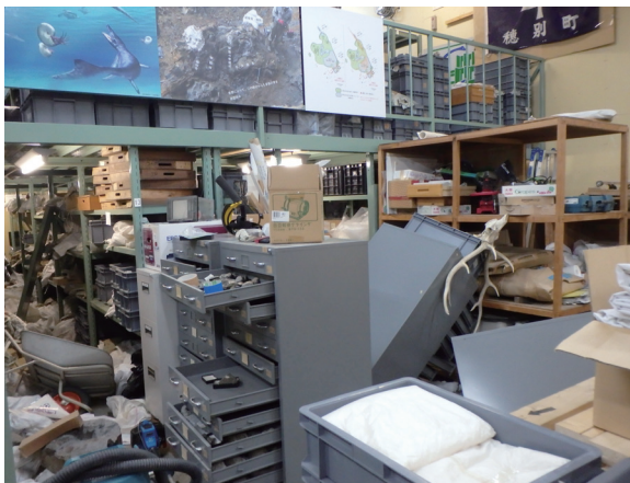
図9. かせき学習館収蔵庫地震被害。2018年9月6日～8日撮影。A–C, 収蔵庫1階。スチール棚に転倒被害が見られた。むかわ竜化石を収蔵していた樹脂製コンテナは移動・転倒しなかった。D, 収蔵庫2階。棚が移動し、通路が狭くなっている。
