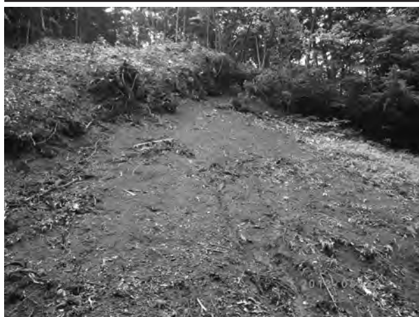
図 17 伐採後の現場状況 (2013.8.20)
