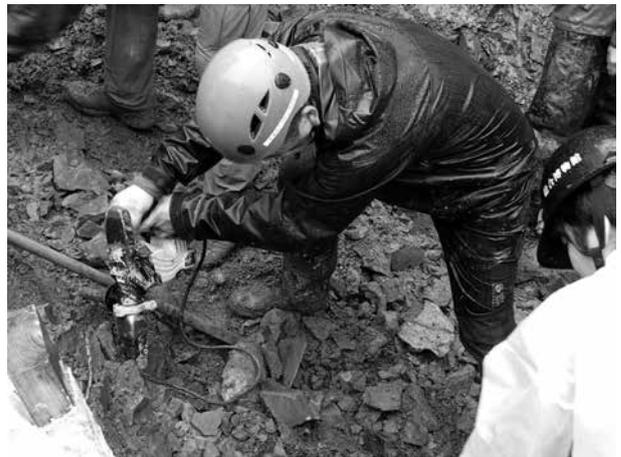
図 65 電動ピックによる掘削
