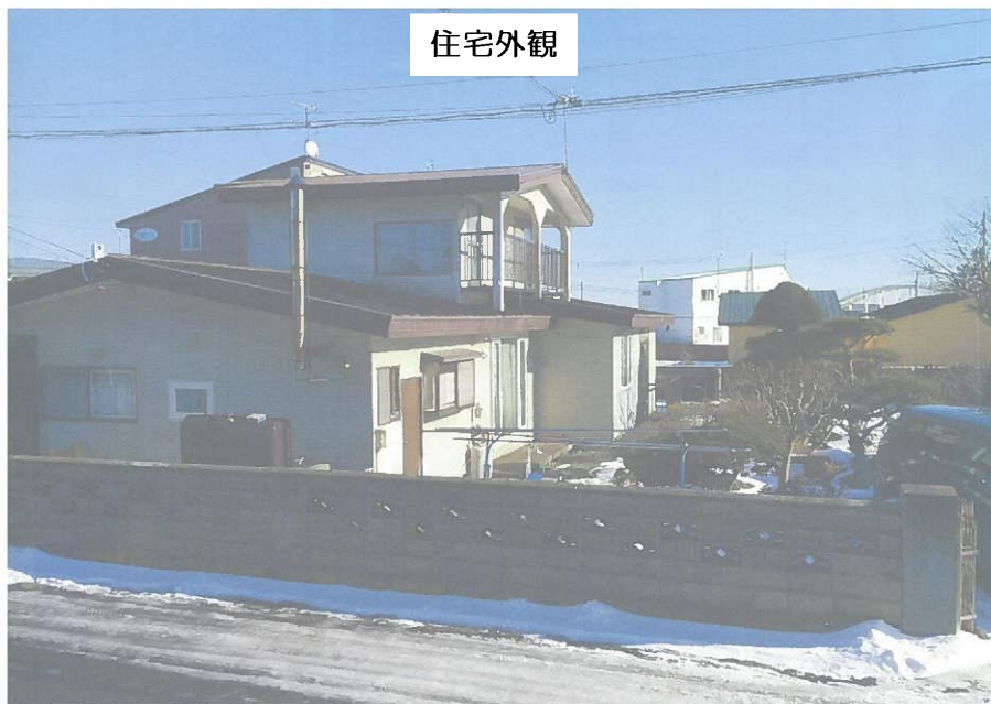
住宅外観(西側)
