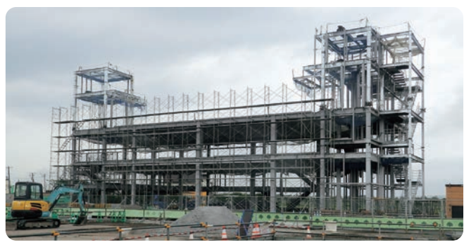
建設中の消防庁舎
