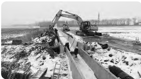
用水路の改修工事
