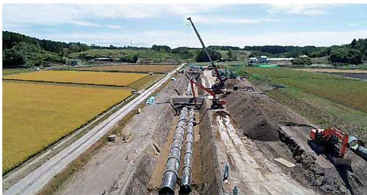
管離脱被災した厚幌導水路の復旧作業〔国土交通省北海道開発局提供〕
