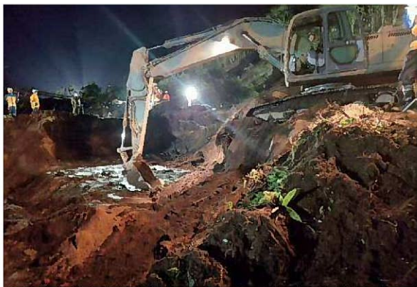
昼夜を問わず続けられた捜索作業(胆振東部消防組合提供)
