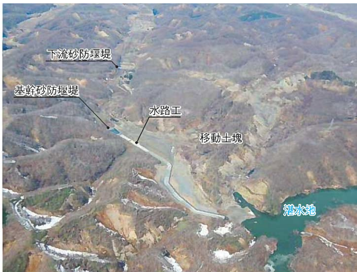
緊急対策工の完成状況(平成31年4月9日撮影)(国土交通省北海道開発局提供)
