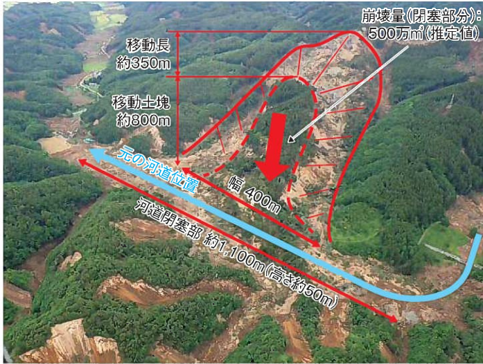
河道閉塞が発生した日高幌内川(平成30年9月8日撮影)(国土交通省北海道開発局提供)
