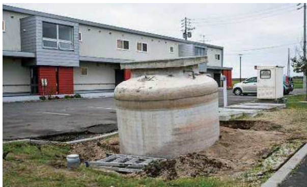
浄化槽 (上厚真地区) 平成 30 (2018) 年 9 月 13 日撮影
