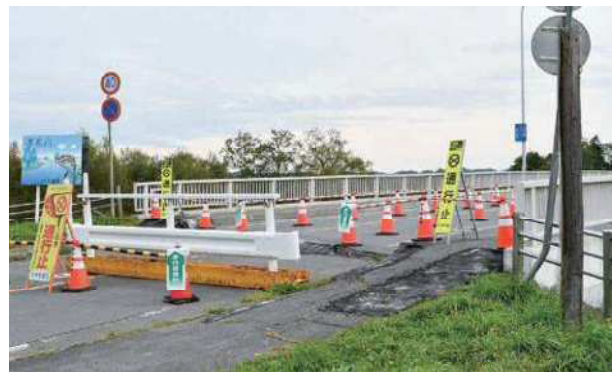
厚真大橋 平成 30 (2018) 年 9 月 27 日撮影
