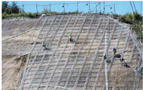
治山復旧工事(東和地区) 令和元(2019)年9月4日撮影
