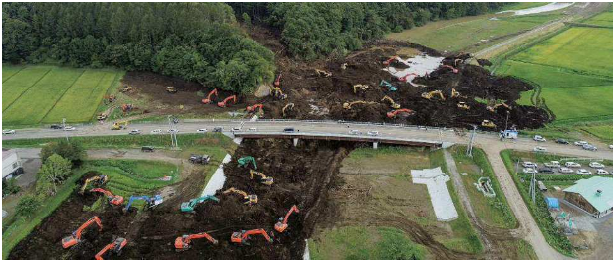
河道掘削作業 (幌内地区) 平成 30 (2018) 年 9 月 9 日撮影 [北海道提供]
