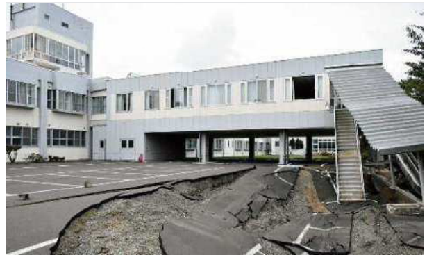
障害者支援施設「厚真リハビリセンター」、特別養護老人ホーム「豊厚園」、あつまデイサービスセンター (本郷地区) 平成 30 (2018) 年 9 月 16 日撮影
