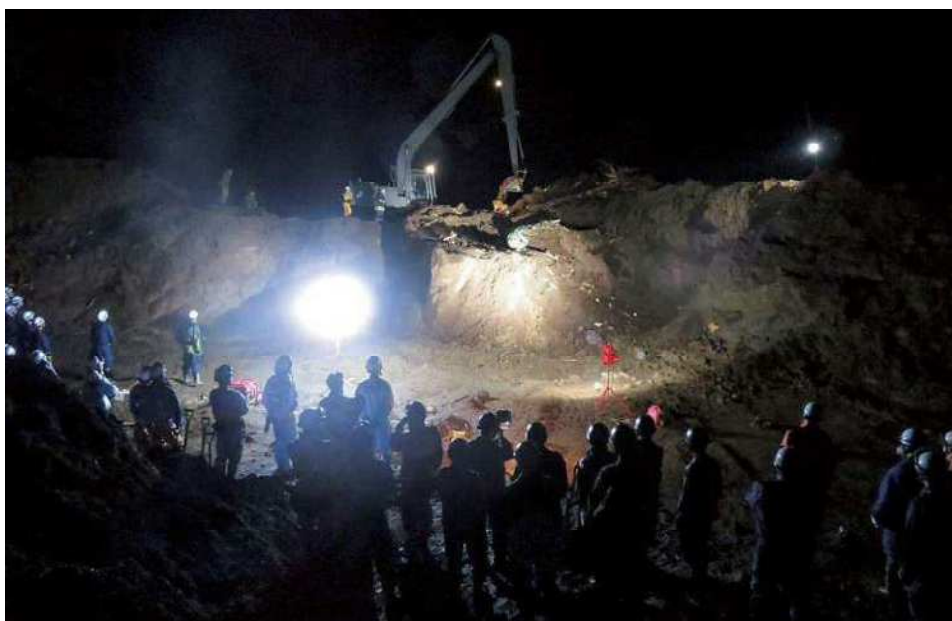
重機で捜索する緊迫した現場【札幌市消防局提供】
