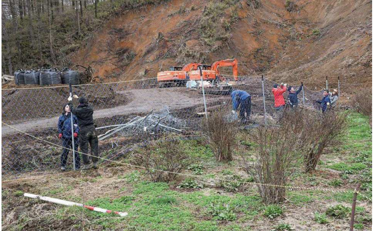
被災した鹿侵入防止策の再設置 平成 31 (2019) 年 4 月 27 日撮影
