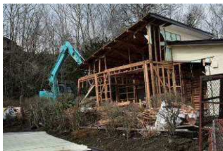
被災家屋の公費解体
