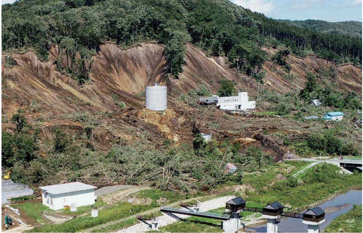
富里浄水場 平成 30 (2018) 年 9 月 6 日撮影 [北海道提供]
