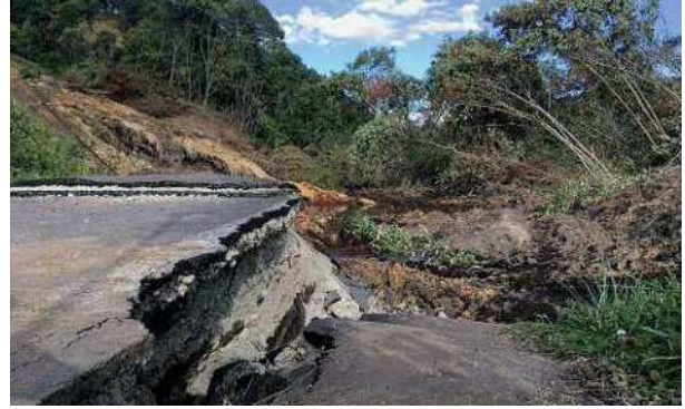
梶里本線 (梶里地区) 平成 30 (2018) 年 9 月 17 日撮影
