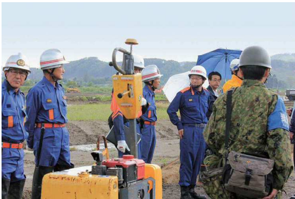
被災現場で活動する職員・団員【胆振東部消防組合提供】
