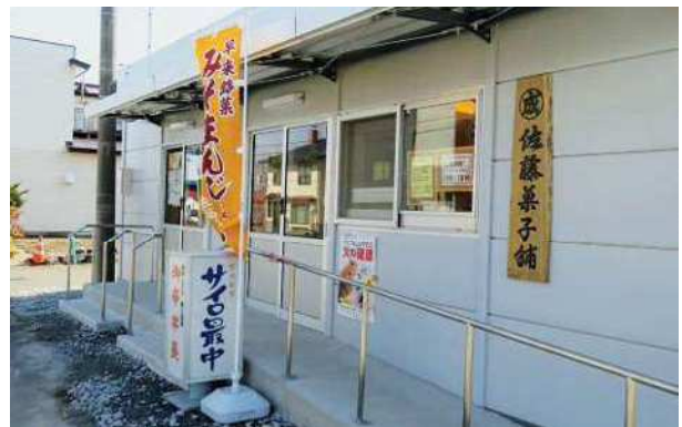
仮設店舗 (早来地区) 平成 31 (2019) 年 4 月 17 日撮影
