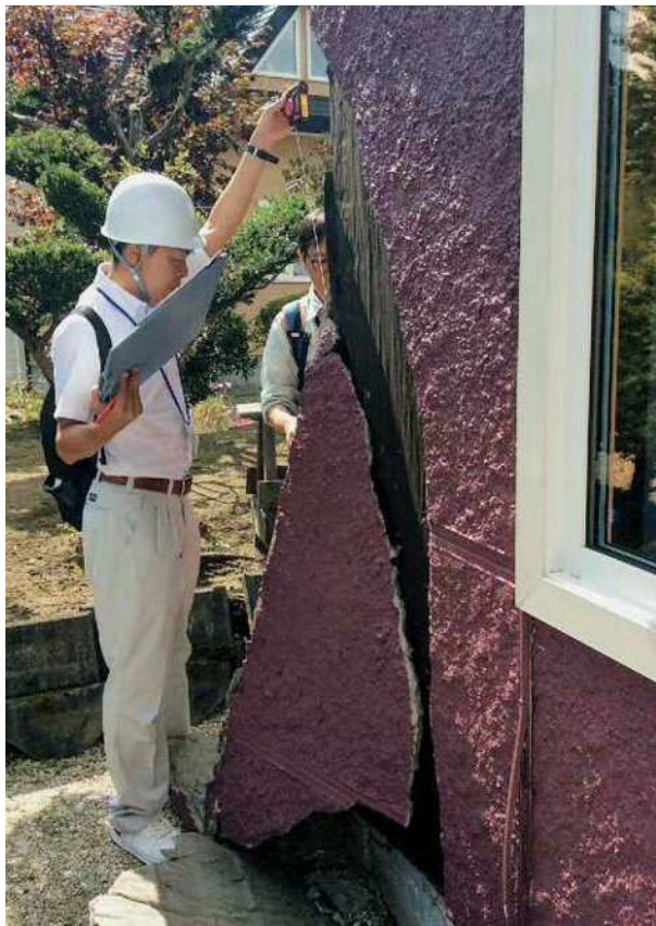
住家被害認定調査 平成 30 (2018) 年 9 月 17 日撮影
