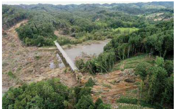
橋梁被害 (瑞穂林道 2 号線) 平成 30 (2018) 年 9 月 13 日撮影
