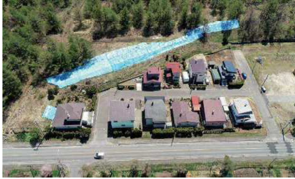
宅地被害 (早来北進地区) 令和元 (2019) 年 5 月 13 日撮影
