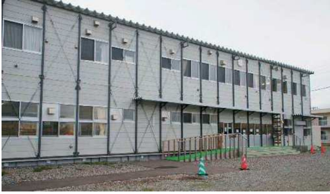
平成31(2019)年1月から使用しているプレハブの仮設校舎
