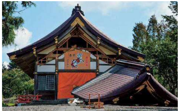
寺院被害 平成 30 (2018) 年 10 月 7 日撮影 [北海道新聞社提供]
