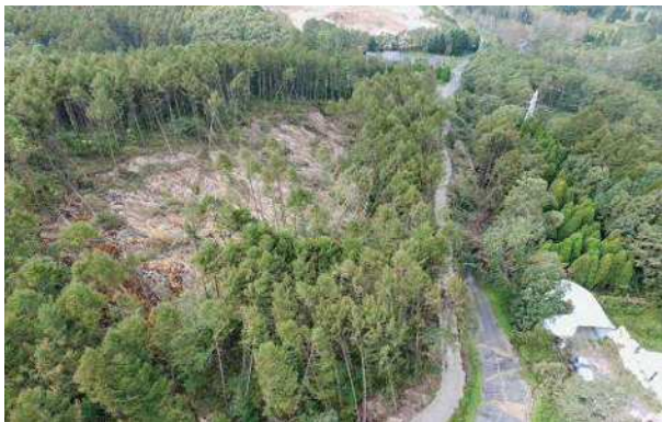
道路被害 (北進焼却場線) 平成 30 (2018) 年 9 月 12 日撮影
