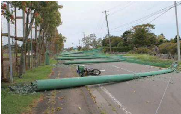
グラウンドネット支柱倒壊 (鶴川高校) 平成 30 (2018) 年 9 月 7 日撮影
