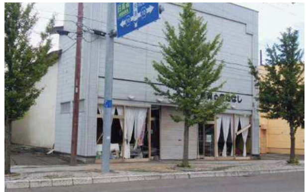
建物被害(鷗川地区) 平成30(2018)年9月6日撮影
