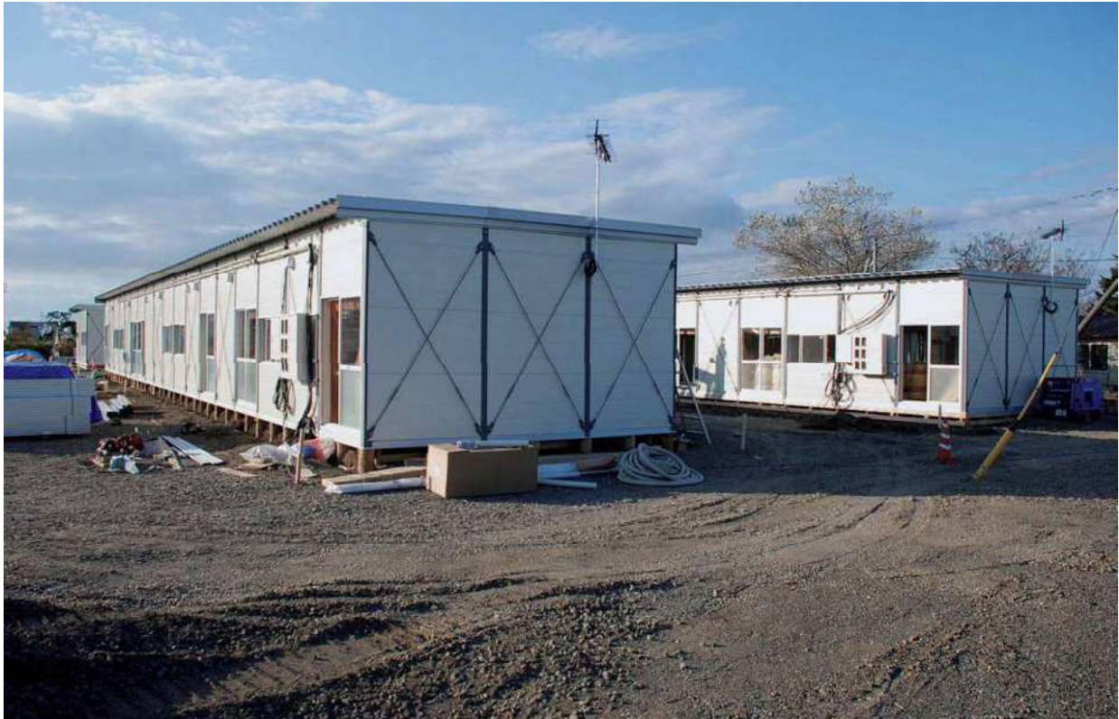
応急仮設住宅 平成 30 (2018) 年 10 月 20 日撮影
