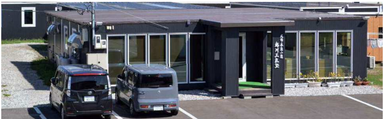
仮設生徒寮 令和元 (2019) 年 9 月 13 日撮影
