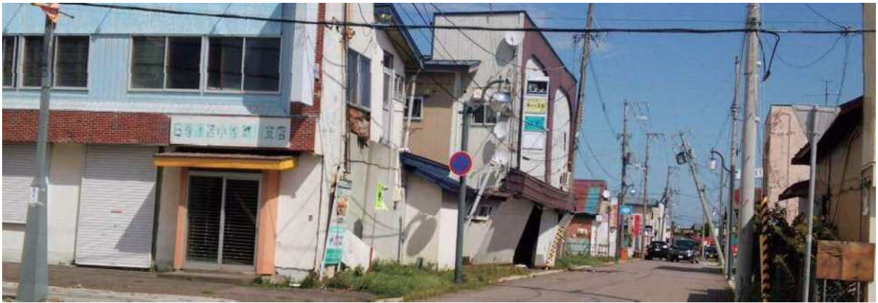
建物被害 (鶴川地区) 平成 30 (2018) 年 9 月 6 日撮影
