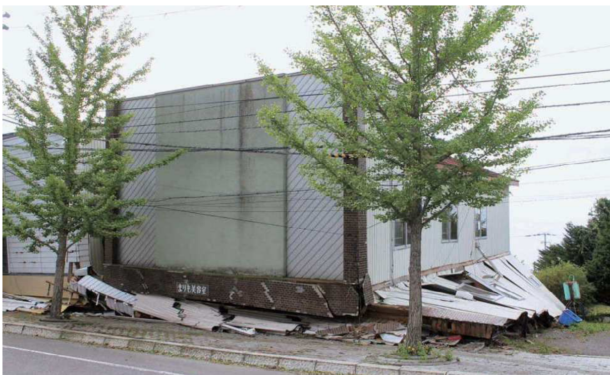
建物被害(鶴川地区) 平成30(2018)年9月6日撮影
