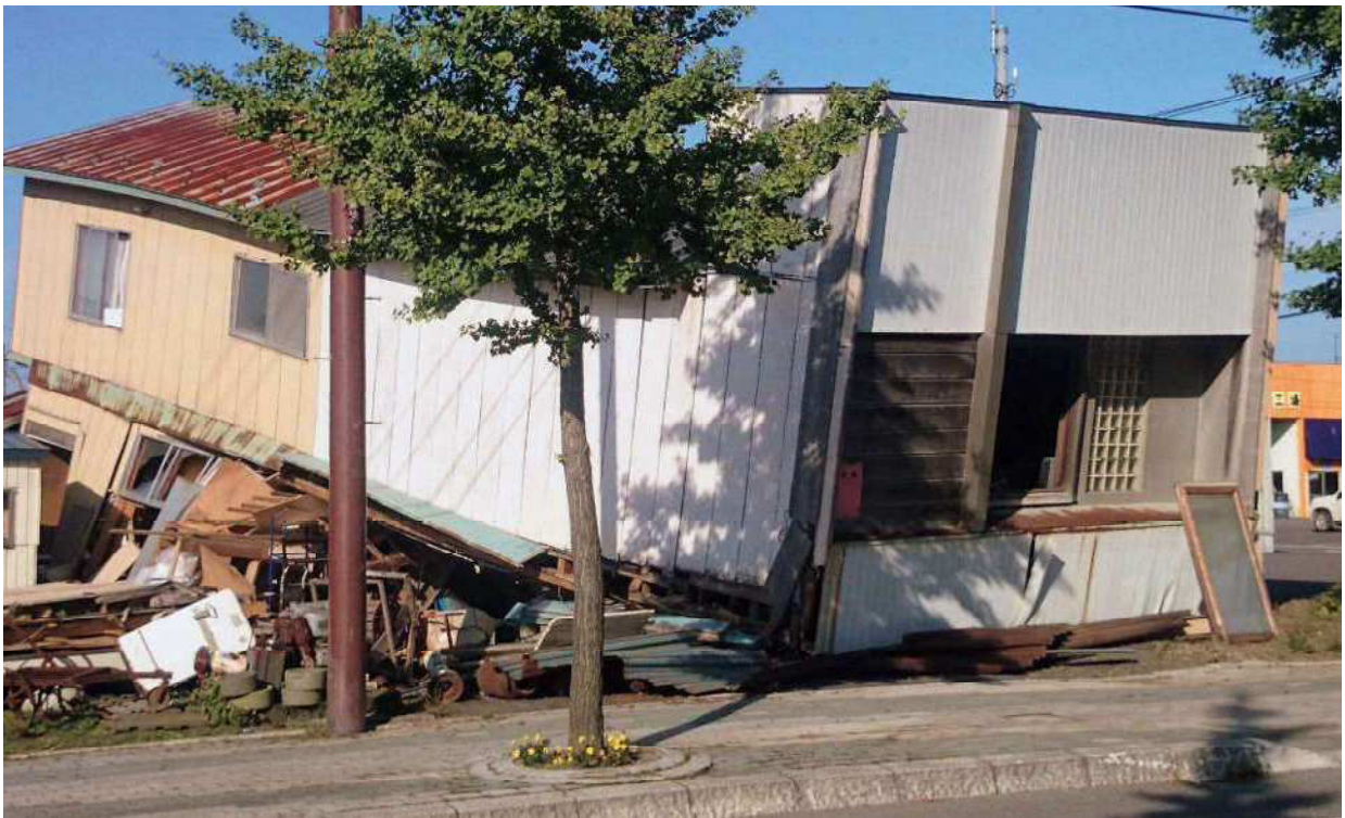
建物被害 (鶴川地区) 平成 30 (2018) 年 9 月 15 日撮影 [北海道新聞社提供]
