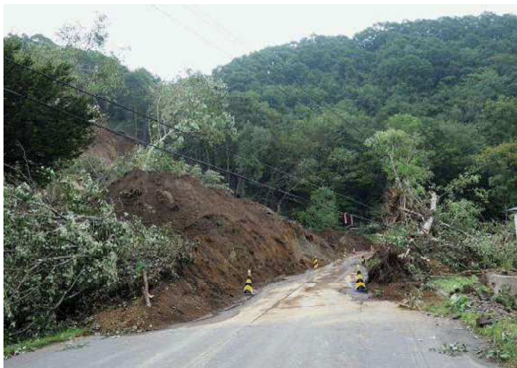
土砂崩れで埋まった穂別地区の道路
