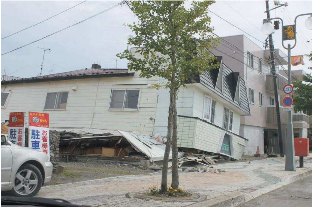
建物被害 (鶴川地区) 平成 30 (2018) 年 9 月 8 日撮影
