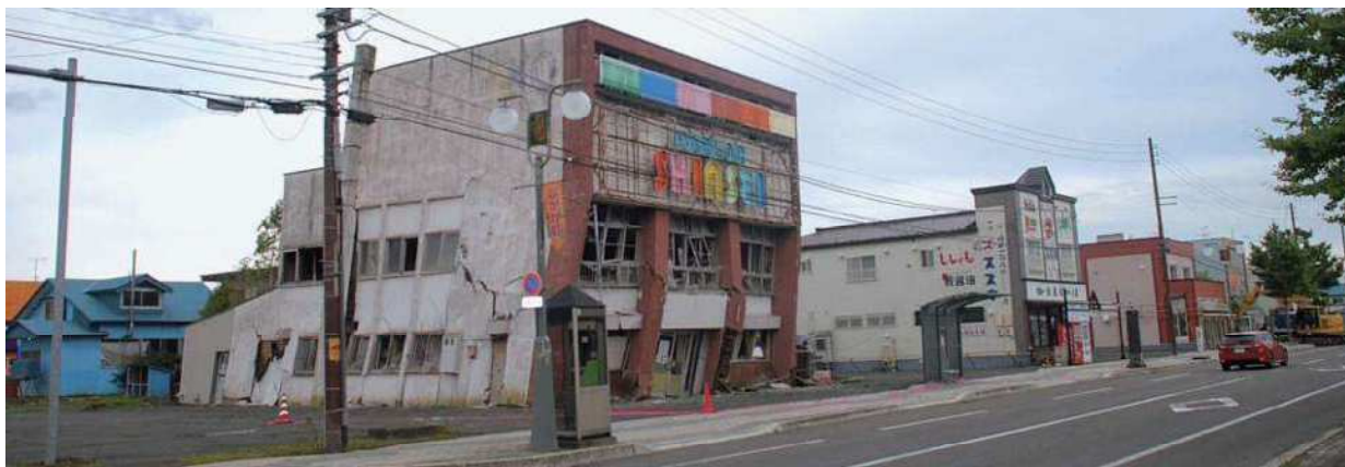
建物被害(鶴川地区) 平成30(2018)年9月8日撮影
