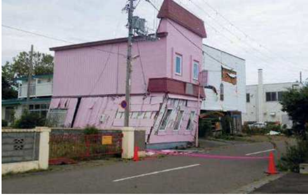
建物被害 (鶴川地区) 平成 30 (2018) 年 9 月 6 日撮影
