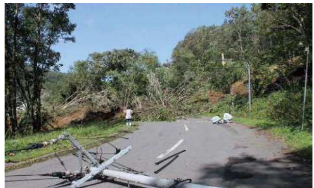
道路被害 (穂別地区) 平成 30 (2018) 年 9 月 6 日撮影
