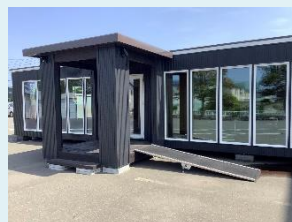
▲役場庁舎横に隣接中のモバイルハウス
