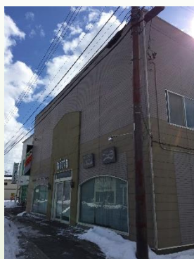
▲被災した空き店舗
