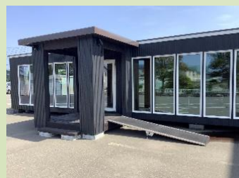
▲役場庁舎横に隣接中のモバイルハウス
