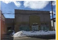
▲被災した空き店舗
