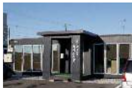
「高校の存続は町の存続と同じ」と、町は被災した寮に代わり迅速に仮設寮の設置を決めた。
