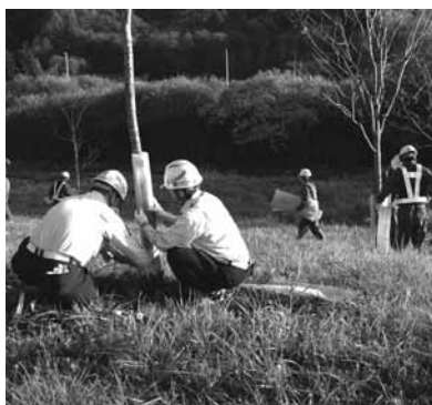
↑鹿等からの食害防止作業を行う工事関係者の皆さん
