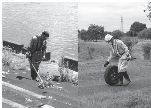
穂別地区 護岸階段の草刈り。
