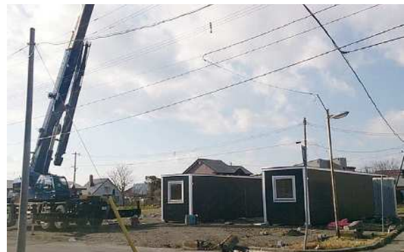
建設中の美幸仮設住宅
