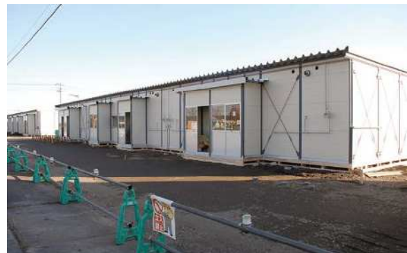
建設中の大原仮設住宅
