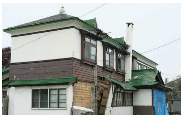
旧鵜川駅通所・旧布施旅館 (松風)
