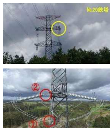
地震の揺れにより①ジャンパー線が ②鉄塔に接触
