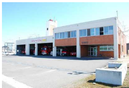
旧鵠川支署庁舎
