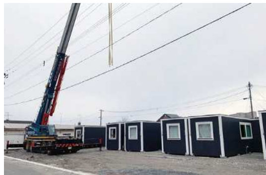
建設中の応急仮設住宅
