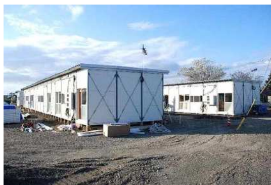
建設中の応急仮設住宅
