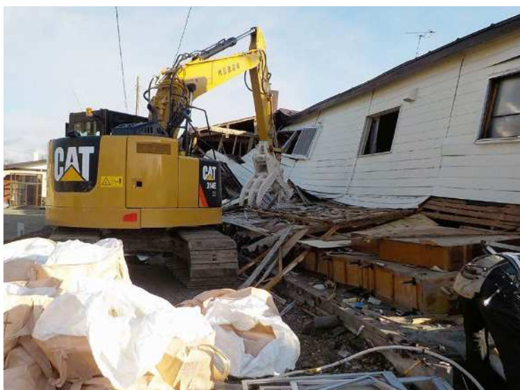
重機による被災家屋解体の様子
