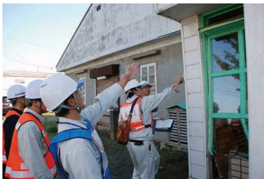
家屋現地調査の様子
