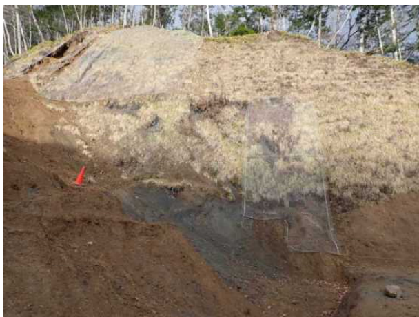
カムイサウルス発掘現場 落石防止ネット（補修後）
